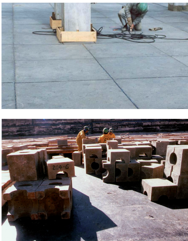
FIGURA 2. Aplicacions del formigó de sofre a l'empresa minera CODELCO (Xile): paviments, elements prefabricats i recobriments per a ambients corrosius.
