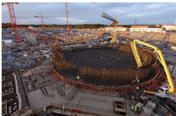
FIGURA 20. Construcció d'una central nuclear EPR de 1.600 MWe a Olkiluoto, Finlàndia, al costat de dues centrals nuclears en operació de 840 MWe cadascuna. Tres fotos il·lustren l'evolució del procés de construcció; la quarta és un fotomuntatge de la situació final. Aquest emplaçament tindrà una potència de 3.280 MWe (Salomaa, 2005).
