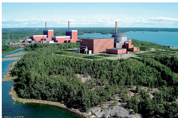
FIGURA 20. Construcció d'una central nuclear EPR de 1.600 MWe a Olkiluoto, Finlàndia, al costat de dues centrals nuclears en operació de 840 MWe cadascuna. Tres fotos il·lustren l'evolució del procés de construcció; la quarta és un fotomuntatge de la situació final. Aquest emplaçament tindrà una potència de 3.280 MWe (Salomaa, 2005).
