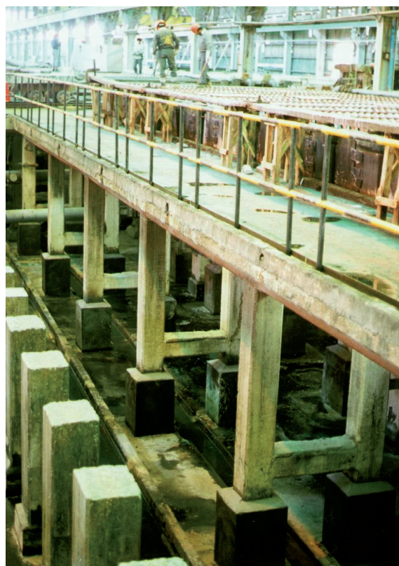
FIGURA 2. Aplicacions del formigó de sofre a l'empresa minera CODELCO (Xile): paviments, elements prefabricats i recobriments per a ambients corrosius.
